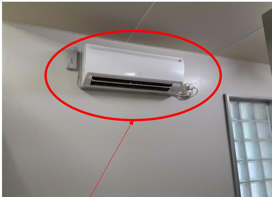
既設室内機と同じ場所に新しい室内機を設置
