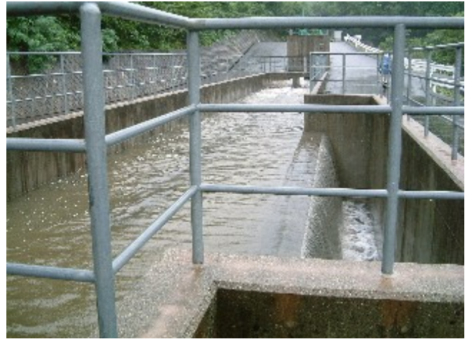
沈砂池・余水吐(下流より)
