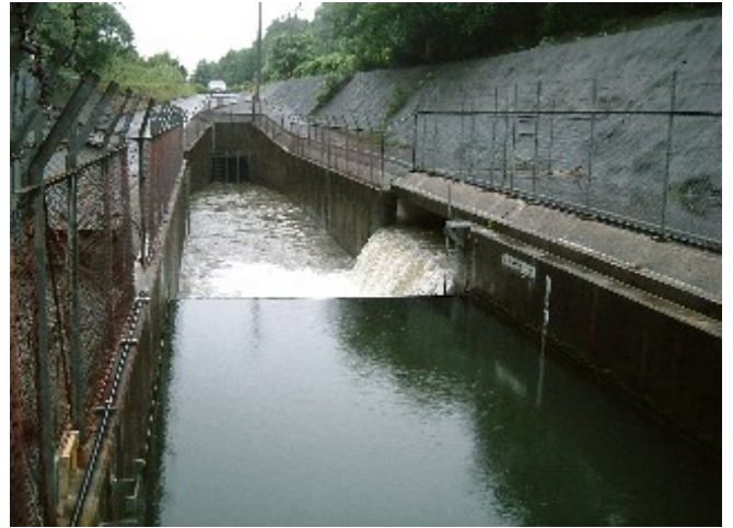
沈砂池・余水吐(下流より)
