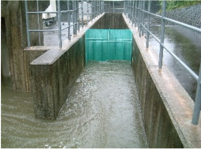
最大取水量規制施設(ディストリビューター) 写真左側は排砂ゲート
