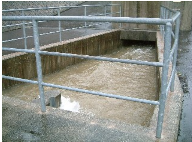
取水ゲート～整流逆勾配区間
