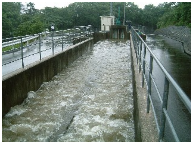
沈砂池～余水吐き 正面が排砂ゲート
