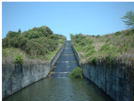
⑪洪水吐きのシュート部と減勢工 写真⑩からの水を下流の河川に水の勢いを減らして放流します。
