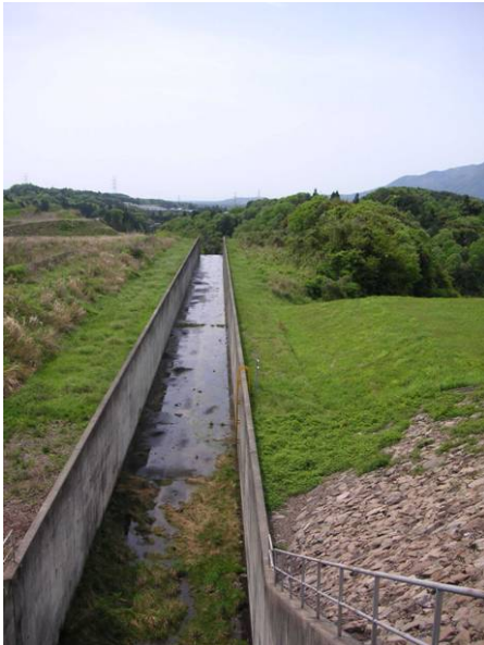
⑩洪水吐きの導流部 写真⑨からの水を下流に流す水路です
