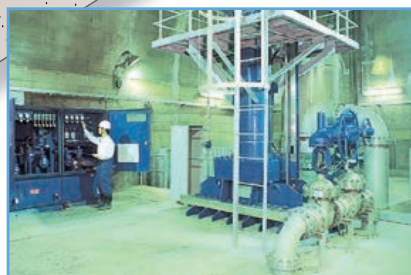
放流管バルブ室
