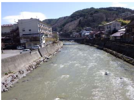
【大手橋地点】 濁度 14.3度
