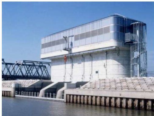
長良導水取水口 (平成10年4月取水開始)
