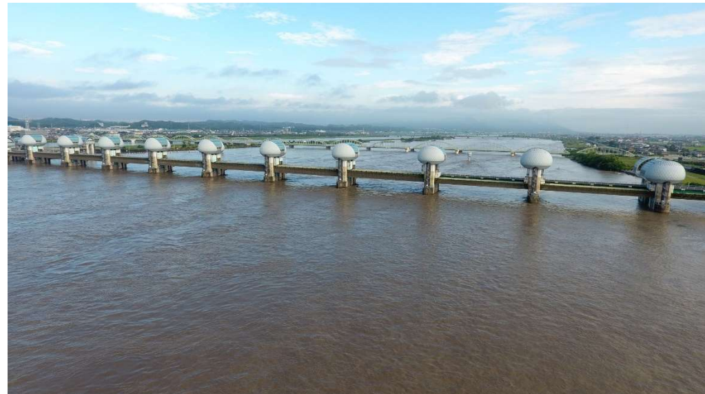
台風7号による出水時の全開操作 (平成30年7月8日撮影)
