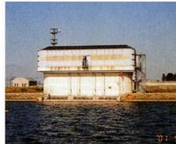
長良導水取水口 (平成10年4月取水開始)
