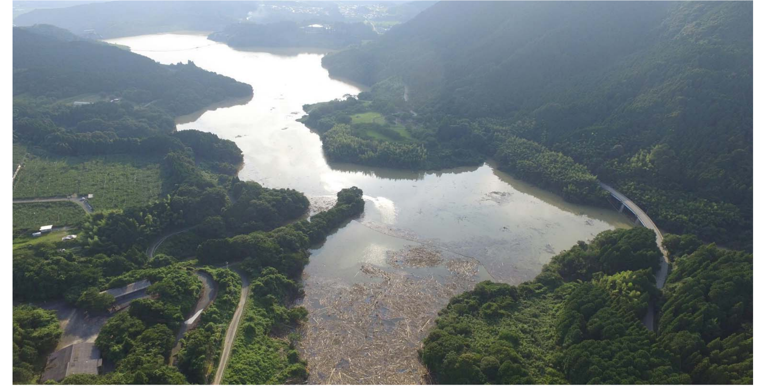
ドローンによる寺内ダム（福岡県朝倉市）の流木捕捉状況調査 写真
