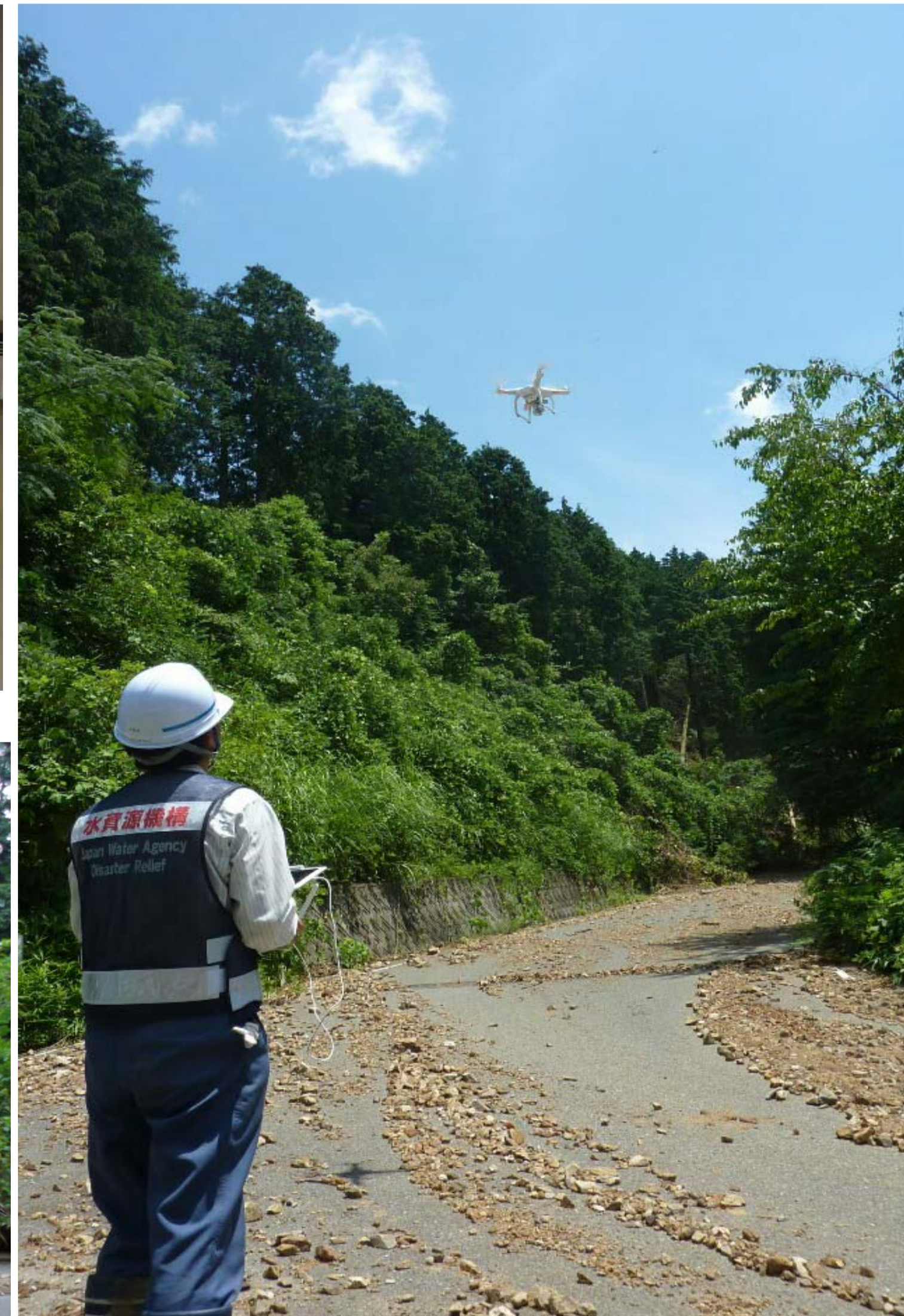
ドローンによる被災状況調査 状況
