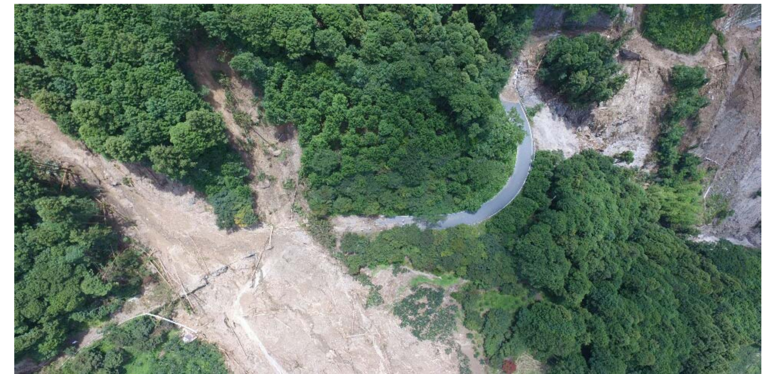
ドローンによる林道被災状況調査（福岡県朝倉市内） 写真
