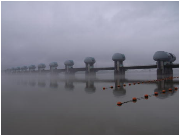
河口堰ゲート全開状況（下流側） 平成23年5月12日10時撮影
