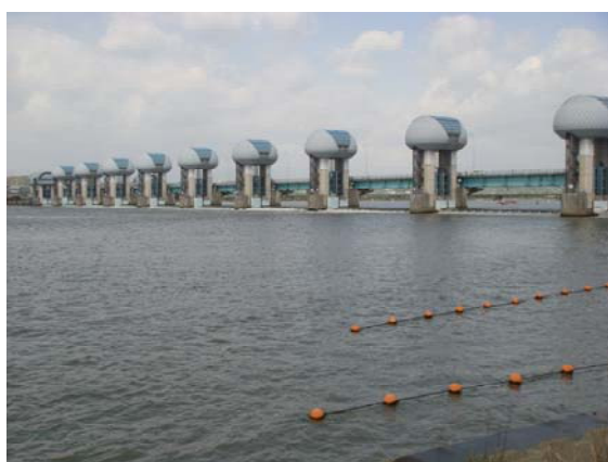
河口堰ゲート状況(下流側) 平成23年5月13日9時撮影
