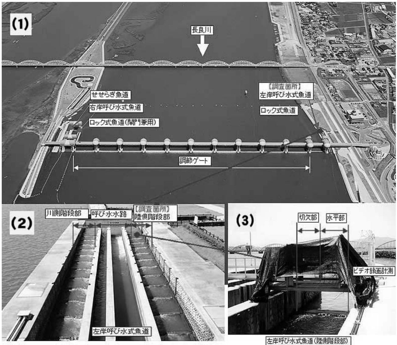
長良川河口堰には、(1)の様に3種類【呼び水式魚道、ロック式魚道、せせらぎ魚道】5カ所の魚道があります。
