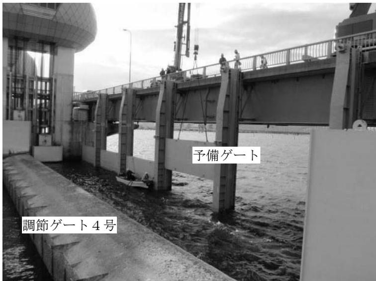
調節ゲート4号に予備ゲートを設置している時の作業状況
