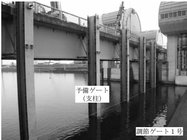
調節ゲート1号に予備ゲートを設置している時の作業状況
