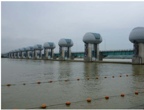
河口堰ゲート状況(下流側) 平成24年6月21日9時撮影
