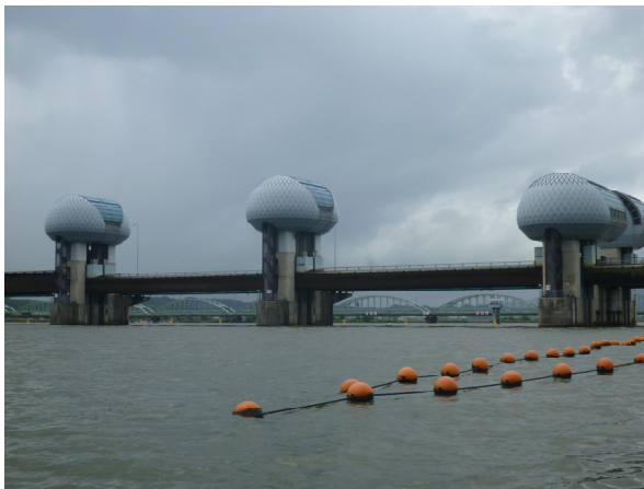
河口堰ゲート全開状況（下流側） 平成24年7月12日14時撮影
