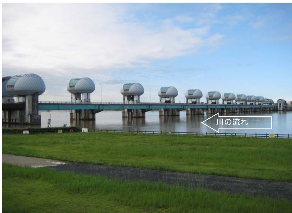
ゲート全開操作の長良川河口堰(堰上流側)
