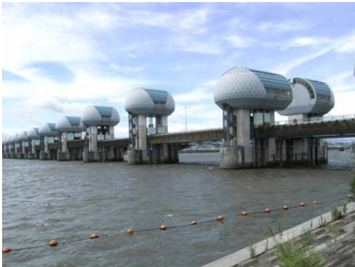
全開操作中の河口堰(下流側) (9月16日 12時撮影)
