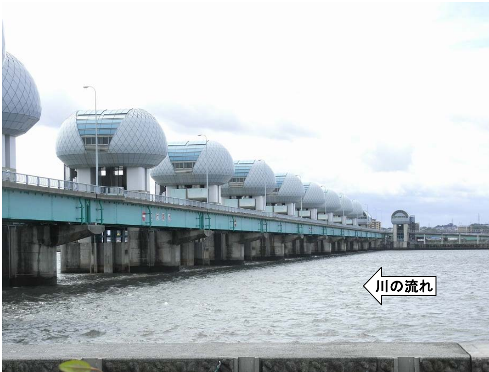
ゲート全開操作時の長良川河口堰(堰上流側)
