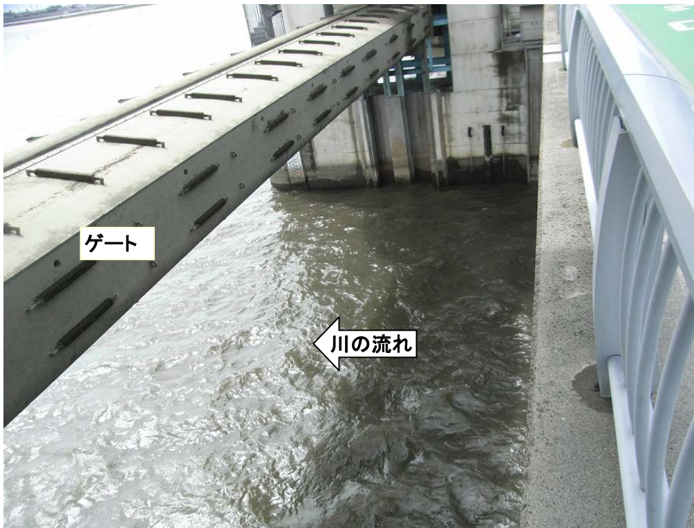
ゲート全開操作時の長良川河口堰(ロック式魚道のゲート)
