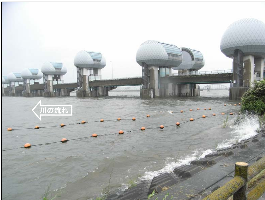
ゲート全開操作の長良川河口堰(堰下流側)
