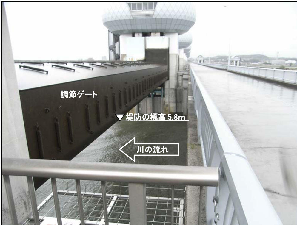
ゲート全開操作の長良川河口堰(堤防より高い位置にゲートを引き上げ)
