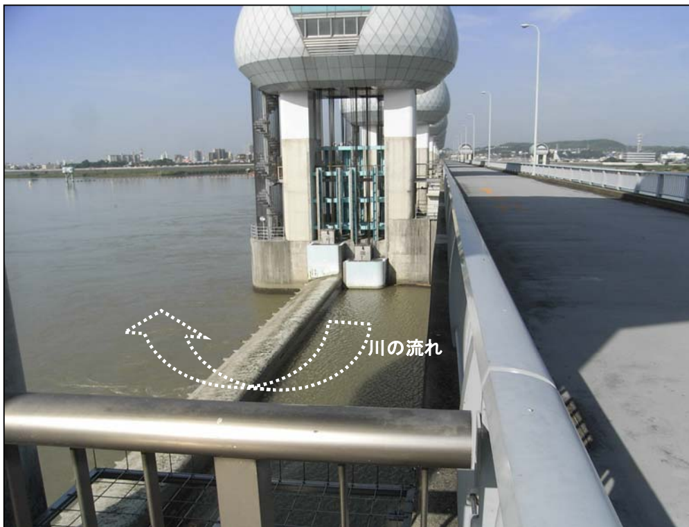
ゲート全開操作終了後の長良川河口堰 (アンダーフロー操作に切り換え:ゲートの下を水が流れています)
