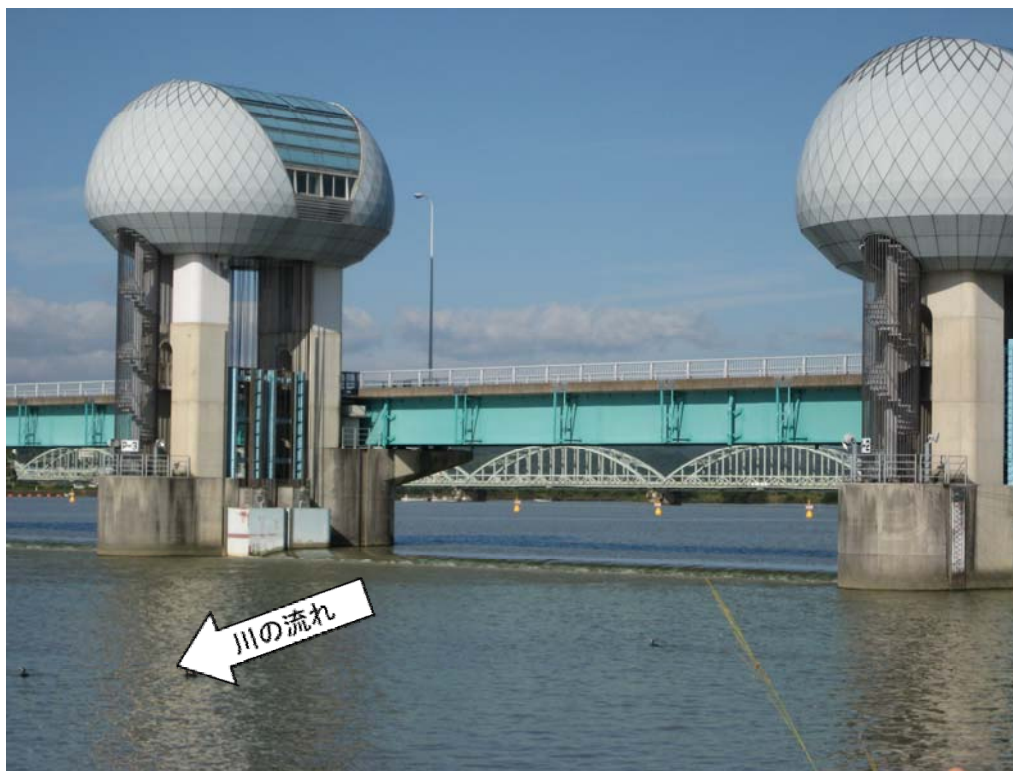
ゲート全開操作終了後の長良川河口堰（オーバーフロー操作に切り替え） 10月 3日 8時30分撮影
