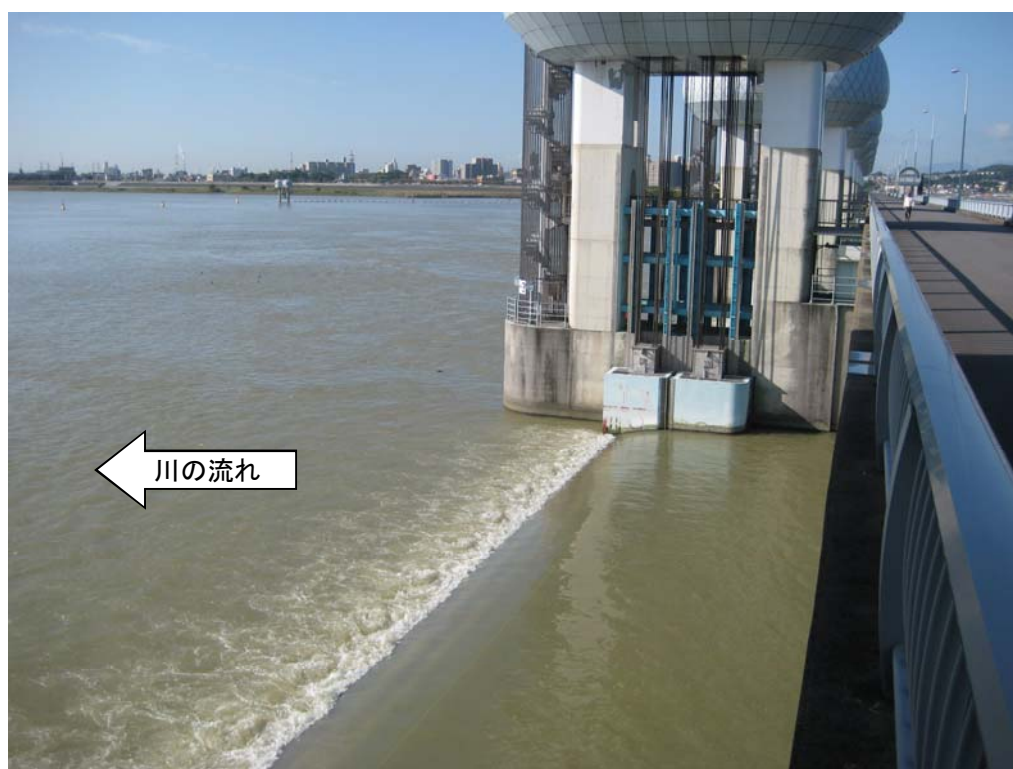
ゲート全開操作終了後の長良川河口堰（オーバーフロー操作に切り替え） 10月 3日 8時30分撮影
