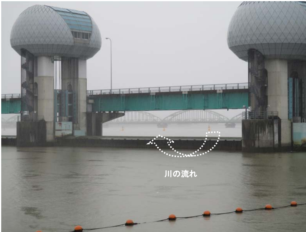
ゲート全開操作終了後の長良川河口堰（アンダーフロー操作に切り替え） 9月22日6時45分撮影
