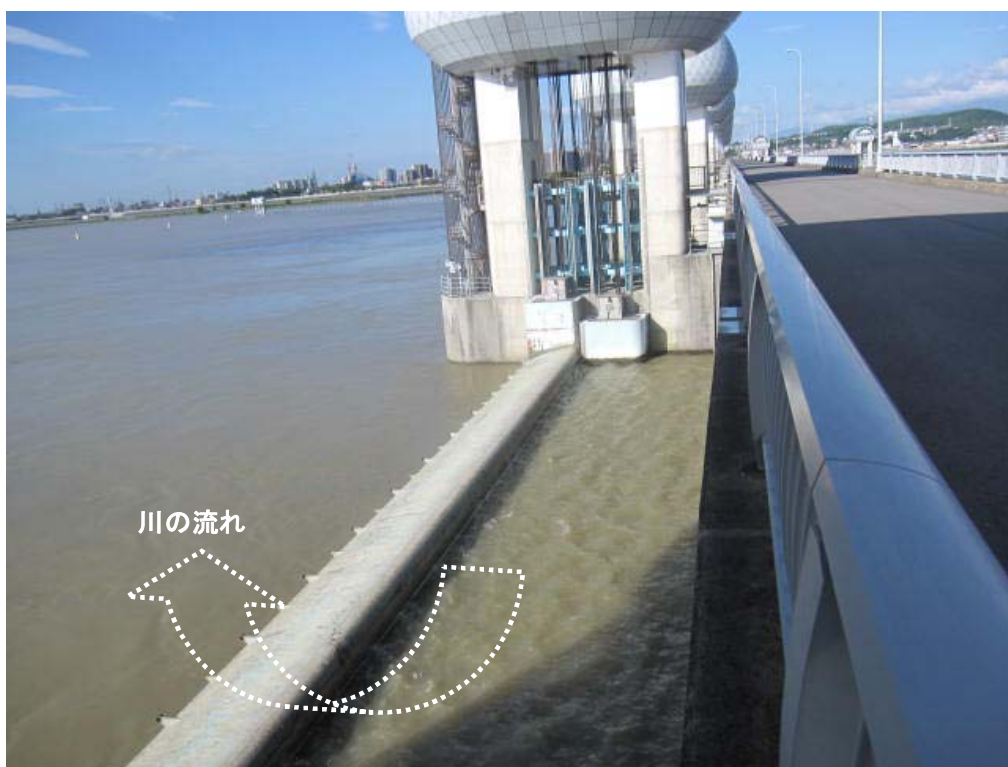
ゲート全開操作終了後の長良川河口堰（アンダーフロー操作に切り替え） 8月9日 7時撮影
