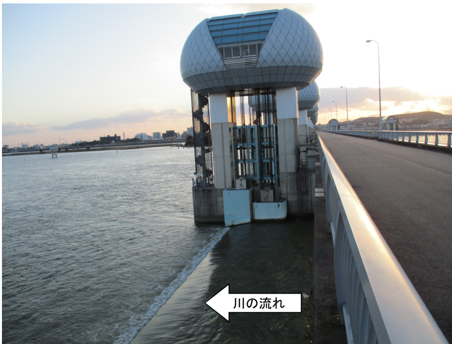
ゲート全開操作終了後の長良川河口堰（オーバーフロー操作に切り替え） 10月30日16時30分撮影
