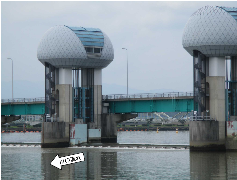
ゲート全開操作終了後の長良川河口堰（オーバーフロー操作に切り替え） 8月31日 12時撮影
