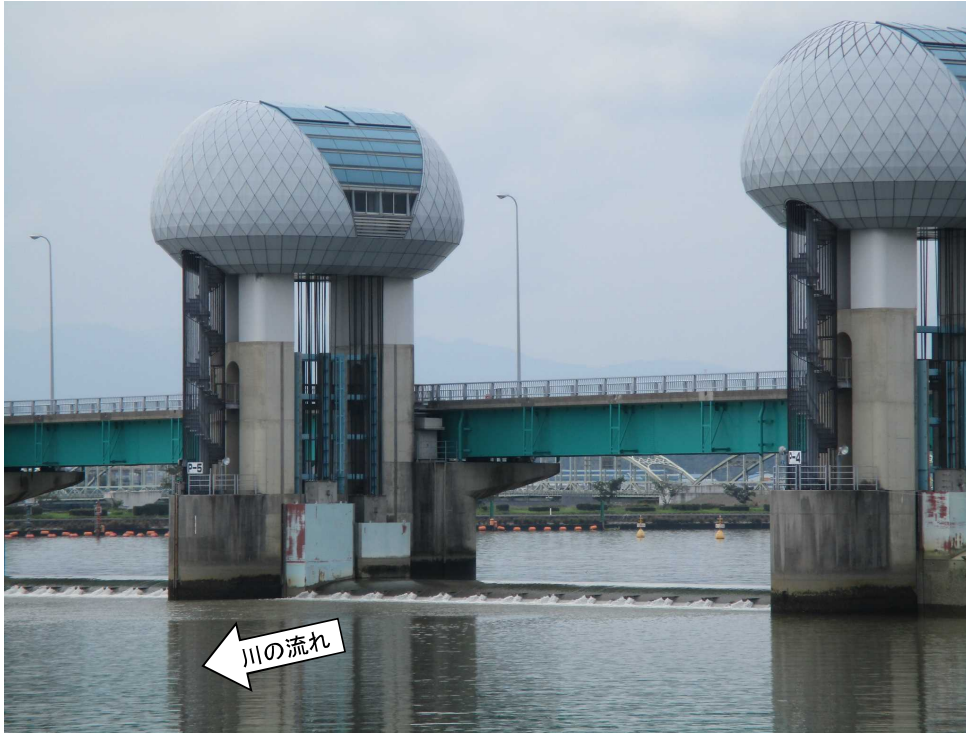
ゲート全開操作終了後の長良川河口堰（オーバーフロー操作に切り替え） 8月31日 12時撮影
