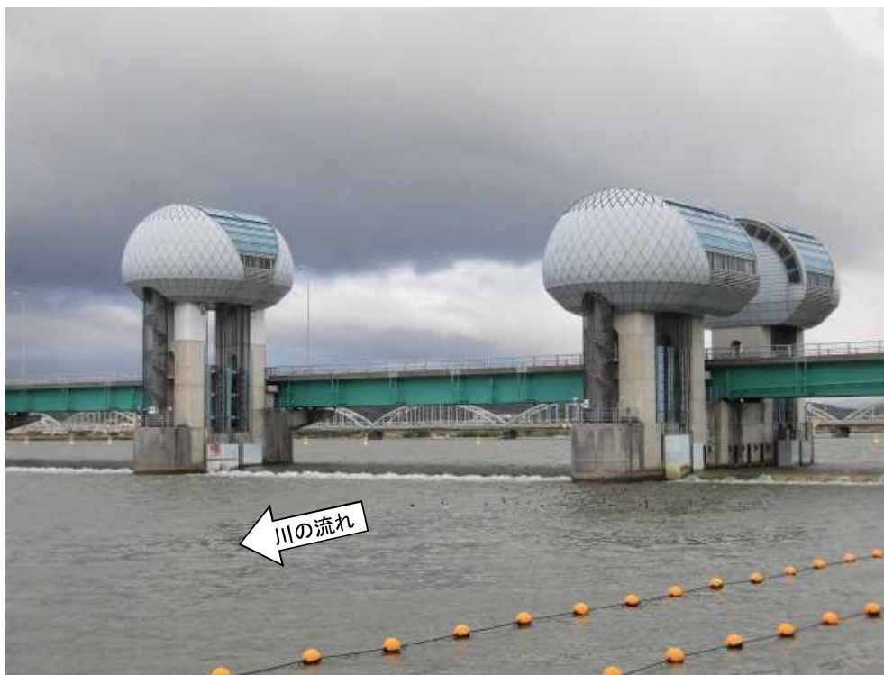
ゲート全開操作終了後の長良川河口堰（オーバーフロー操作に切り替え） 4月19日 7時撮影
