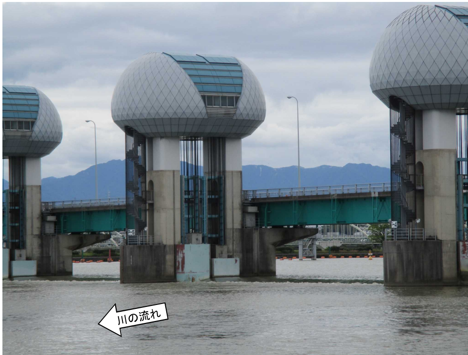
ゲート全開操作終了後の長良川河口堰（オーバーフロー操作に切り替え） 7月2日15時撮影
