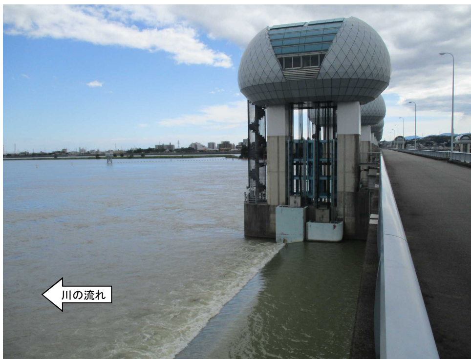
ゲート全開操作終了後の長良川河口堰（オーバーフロー操作に切り替え） 7月2日15時撮影
