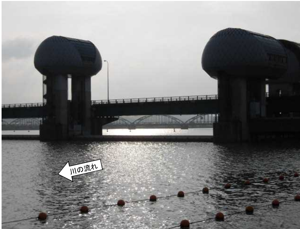
ゲート全開操作終了後の長良川河口堰 (1回目)
