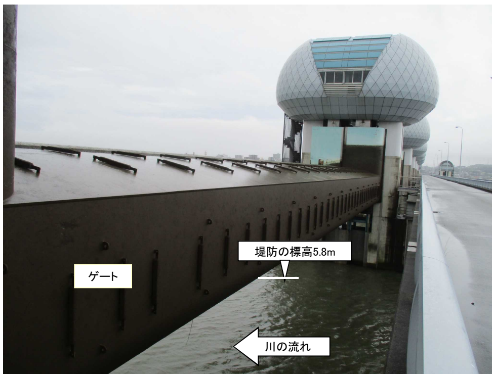
ゲート全開操作開始後の長良川河口堰（堤防より高い位置にゲートを引き上げ） （2回目）
