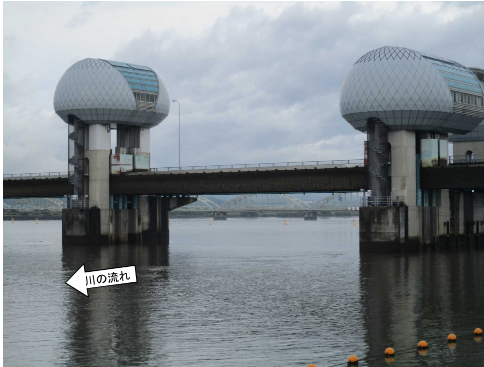
ゲート全開操作開始後の長良川河口堰（堰下流側） （1回目） 7月4日10時撮影
