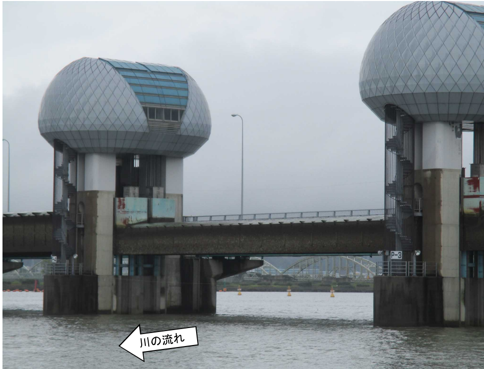
ゲート全開操作開始後の長良川河口堰（堰下流側） （2回目） 7月6日8時撮影
