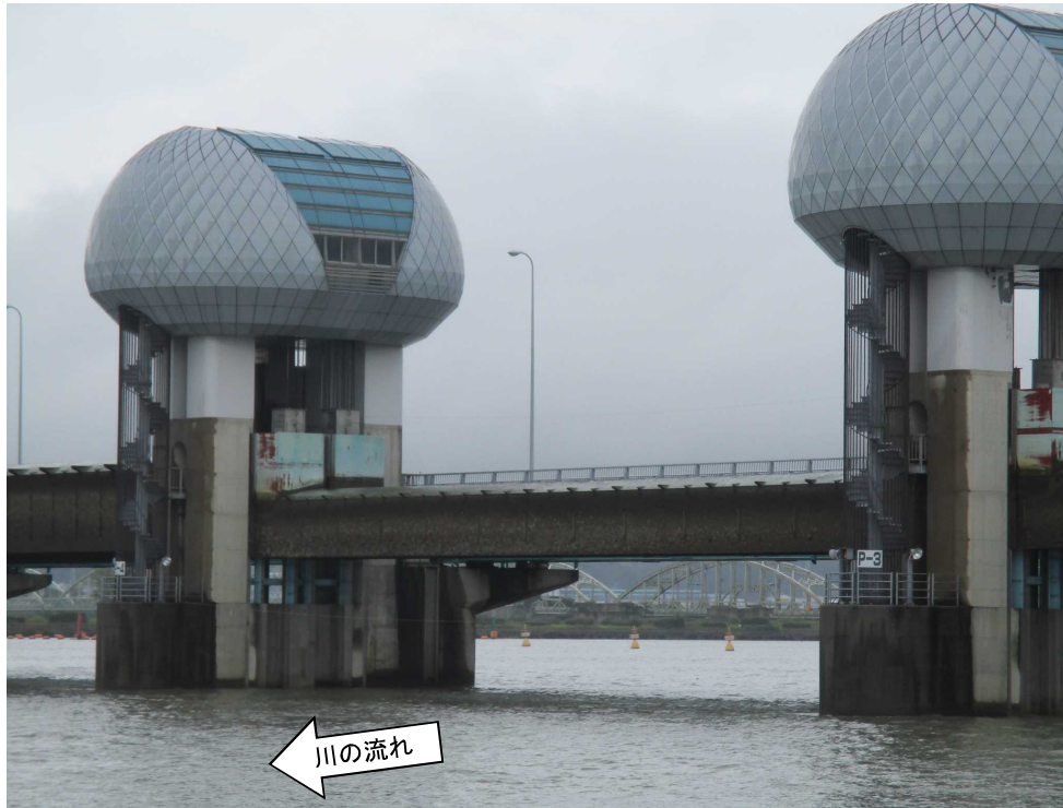
ゲート全開操作開始後の長良川河口堰（堰下流側）
