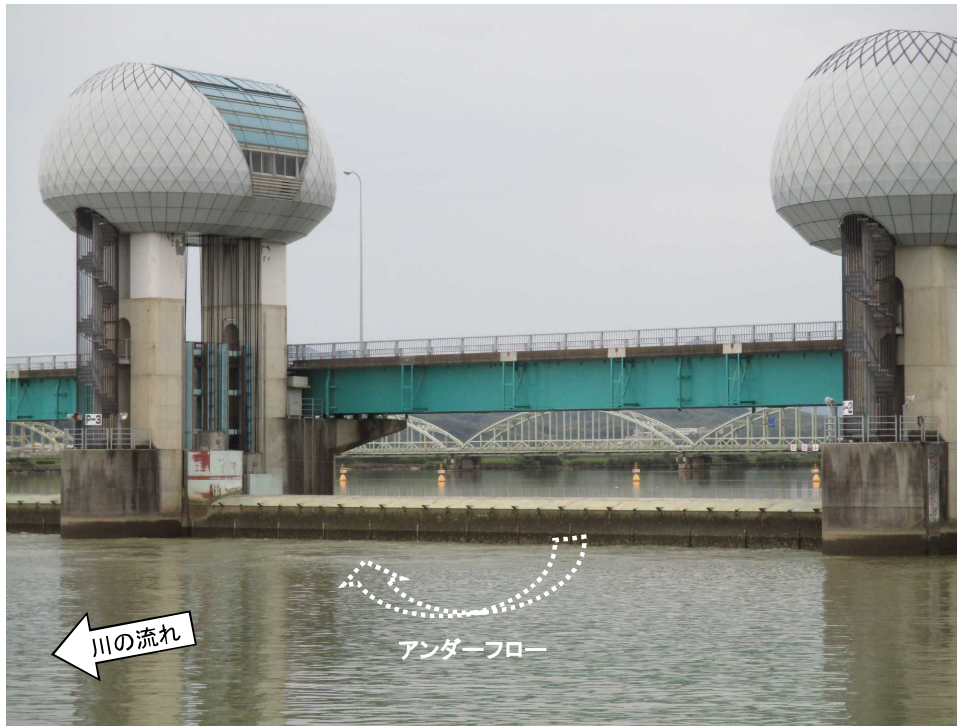
ゲート全開操作終了後の長良川河口堰（アンダーフロー操作に切り替え） 7月13日5時30分撮影
