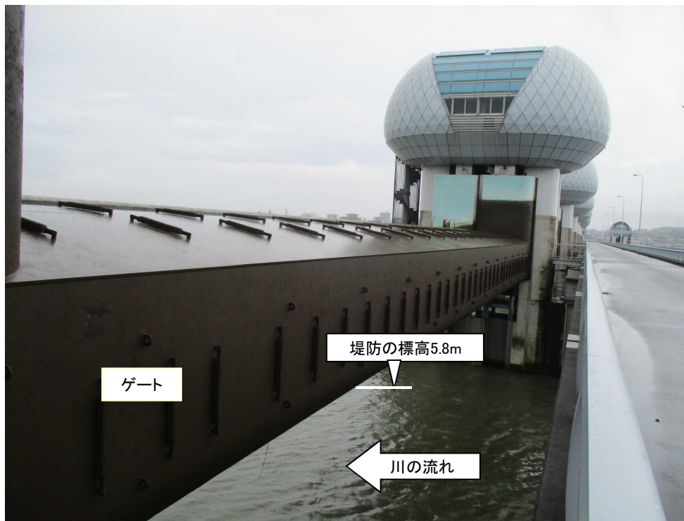
ゲート全開操作開始後の長良川河口堰（堤防より高い位置にゲートを引き上げ）
