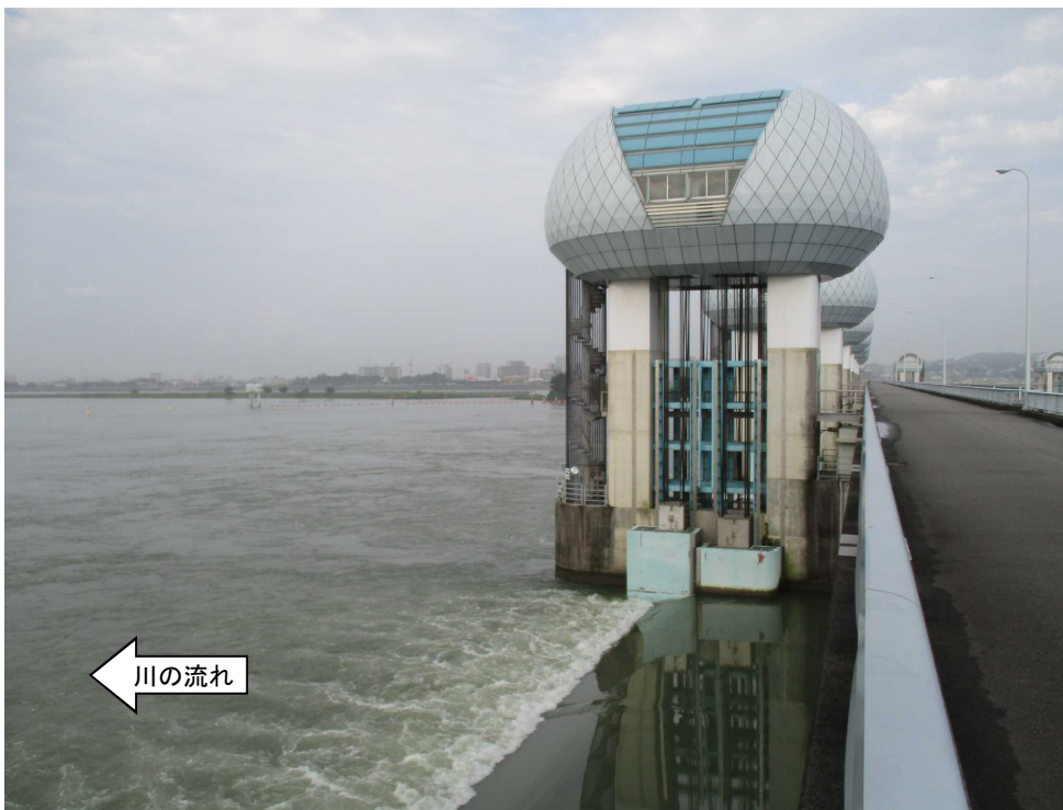
ゲート全開操作終了後の長良川河口堰（オーバーフロー操作に切り替え） 7月19日 6時30分撮影
