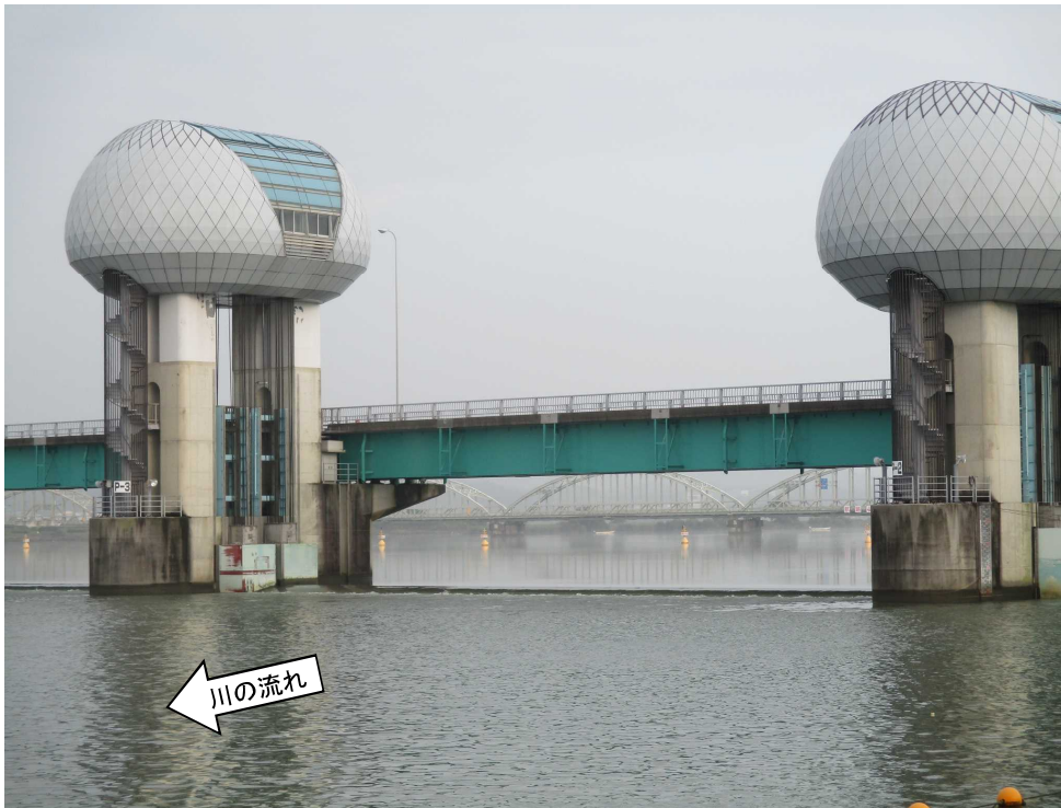
ゲート全開操作終了後の長良川河口堰（オーバーフロー操作に切り替え） 7月19日 6時30分撮影
