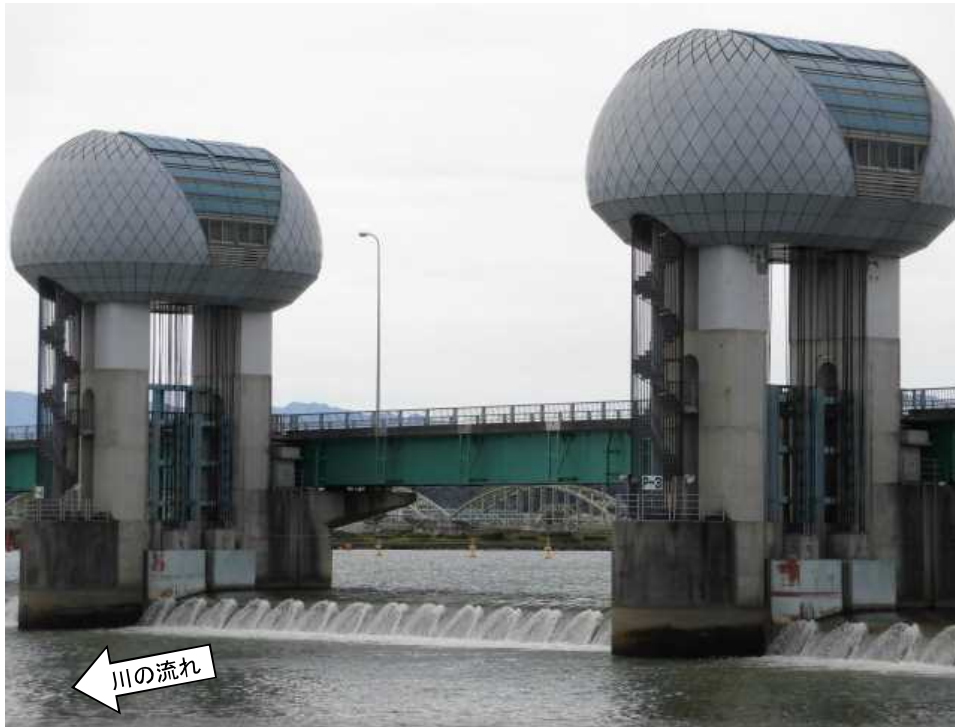
ゲート全開操作終了後の長良川河口堰（オーバーフロー操作に切り替え） （1回目）
