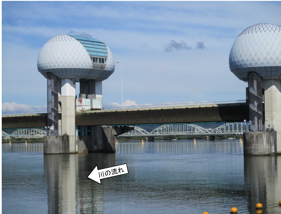
ゲート全開操作開始後の長良川河口堰（堰下流側） （1回目）
