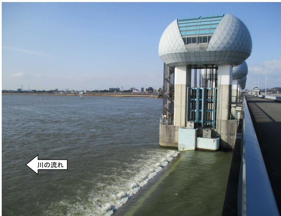
ゲート全開操作終了後の長良川河口堰（オーバーフロー操作に切り替え） 3月22日 8時撮影
