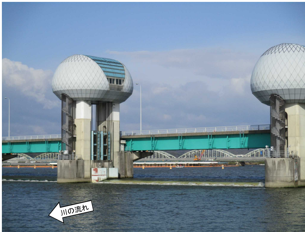
ゲート全開操作終了後の長良川河口堰（オーバーフロー操作に切り替え） 3月22日 8時撮影
