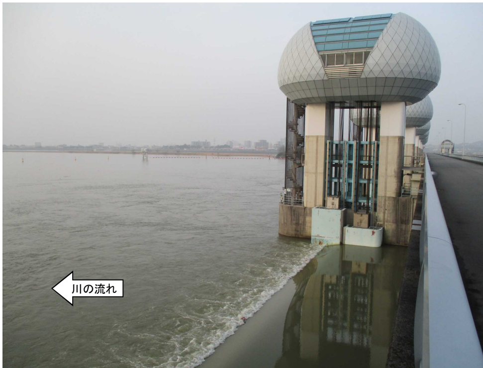
ゲート全開操作終了後の長良川河口堰（オーバーフロー操作に切り替え） 3月30日 6時撮影
