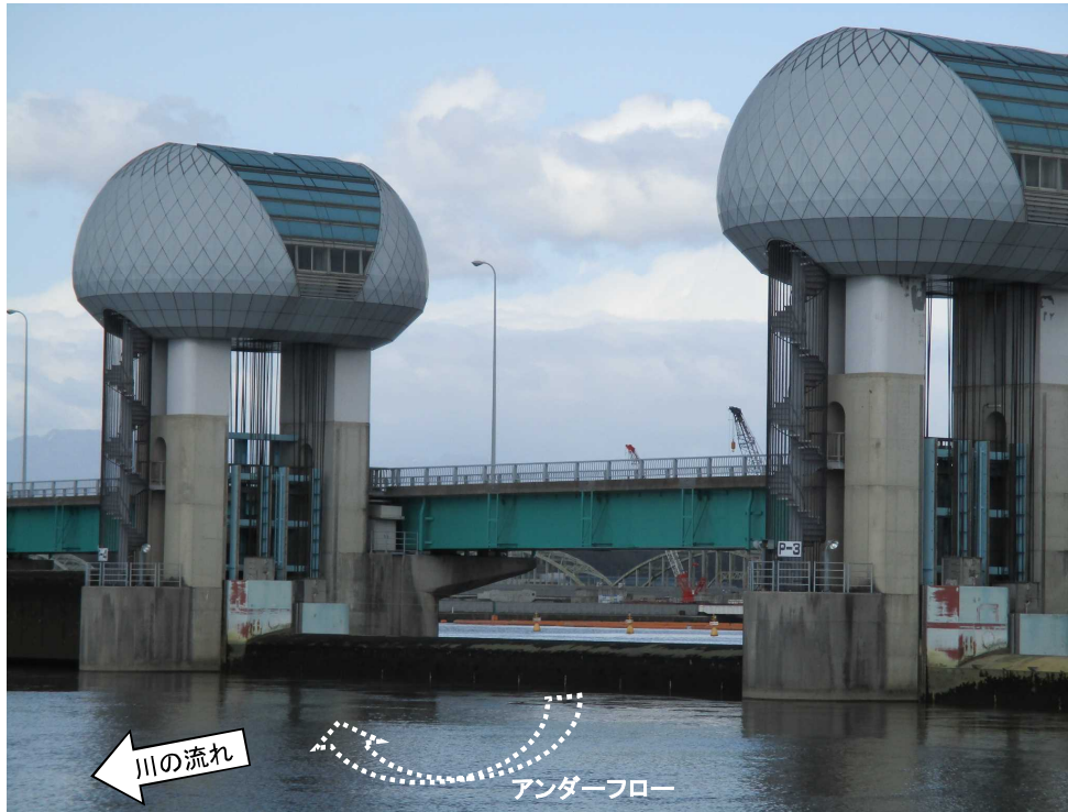
ゲート全開操作終了後の長良川河口堰（アンダーフロー操作に切り替え） 4月18日 10時撮影
