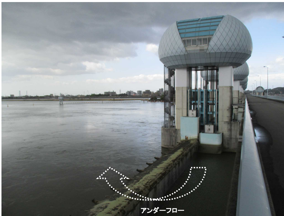
ゲート全開操作終了後の長良川河口堰（アンダーフロー操作に切り替え） 4月18日 10時撮影
