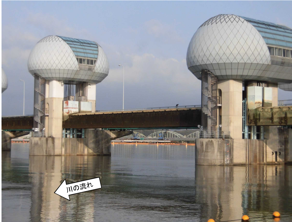
ゲート全開操作開始後の長良川河口堰（堰下流側） （1回目） 4月30日6時撮影
