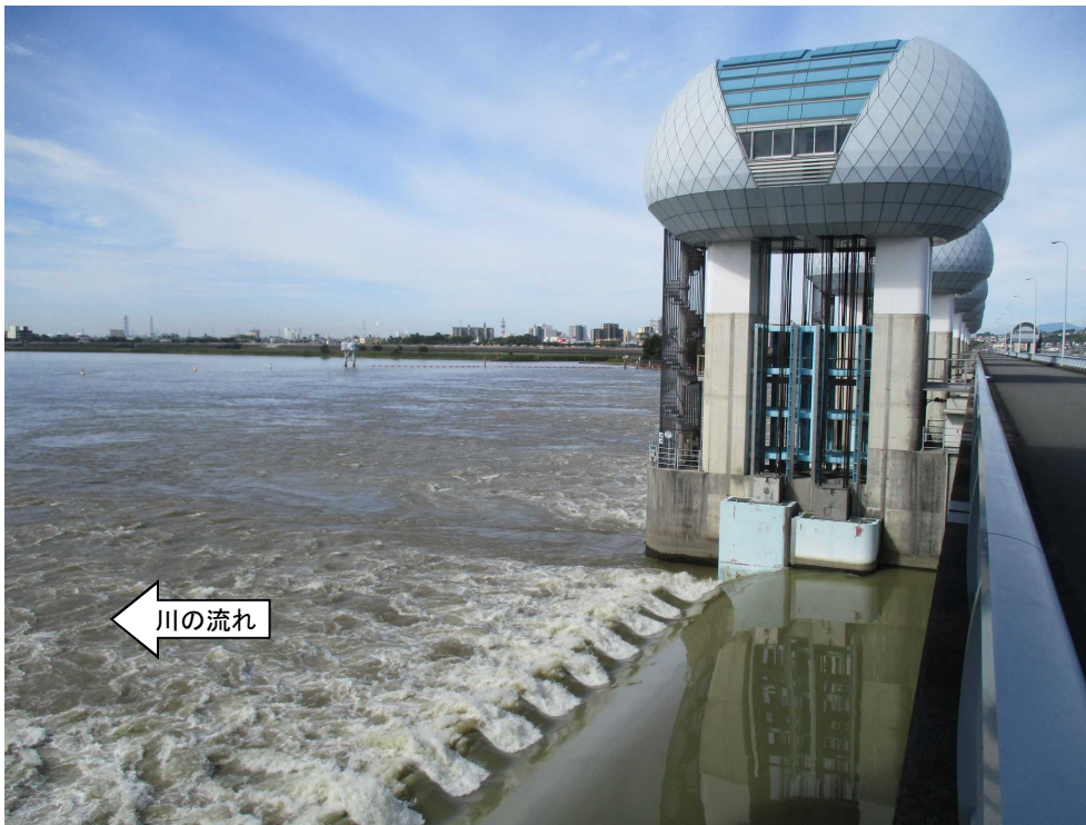
ゲート全開操作終了後の長良川河口堰（オーバーフロー操作に切り替え） 6月5日 9時撮影
