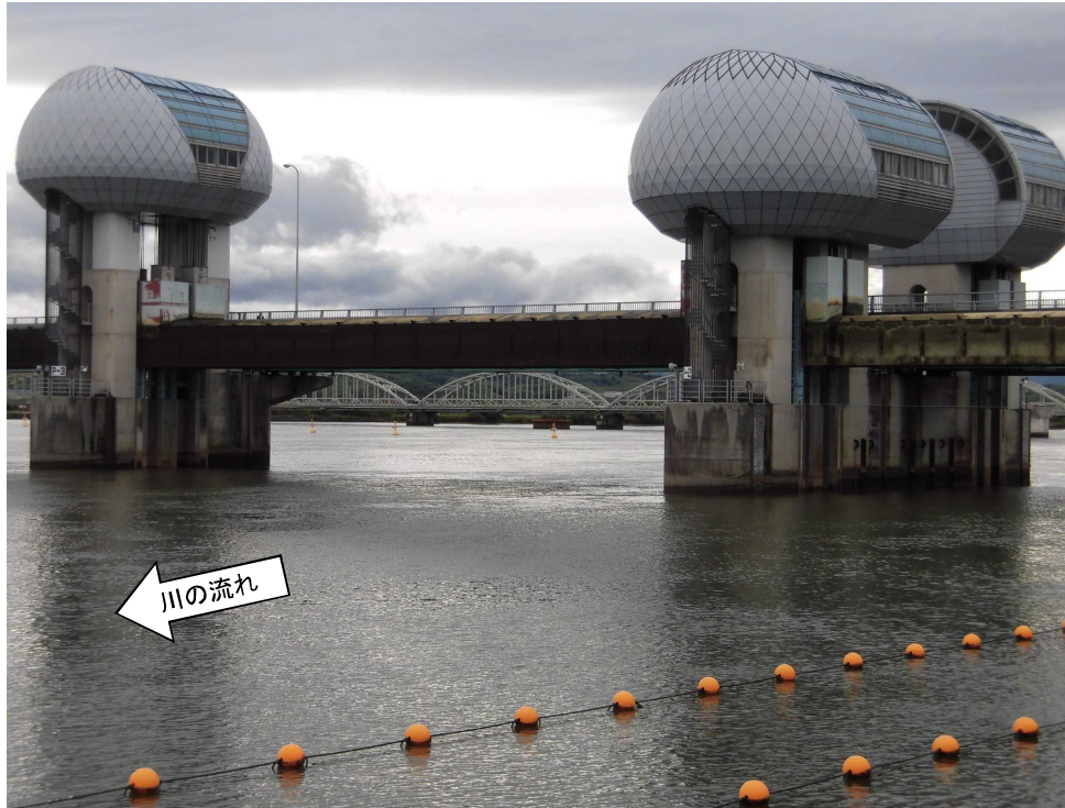
ゲート全開操作開始後の長良川河口堰（堰下流側）
