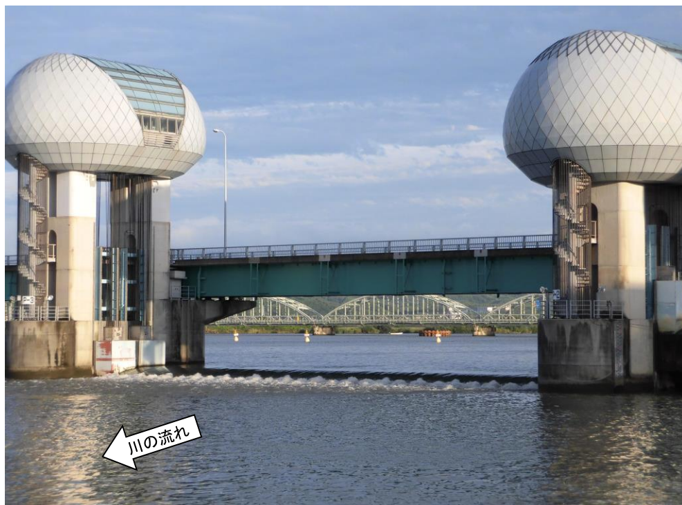
ゲート全開操作終了後の長良川河口堰（オーバーフロー操作に切り替え） 6月20日 5時撮影
