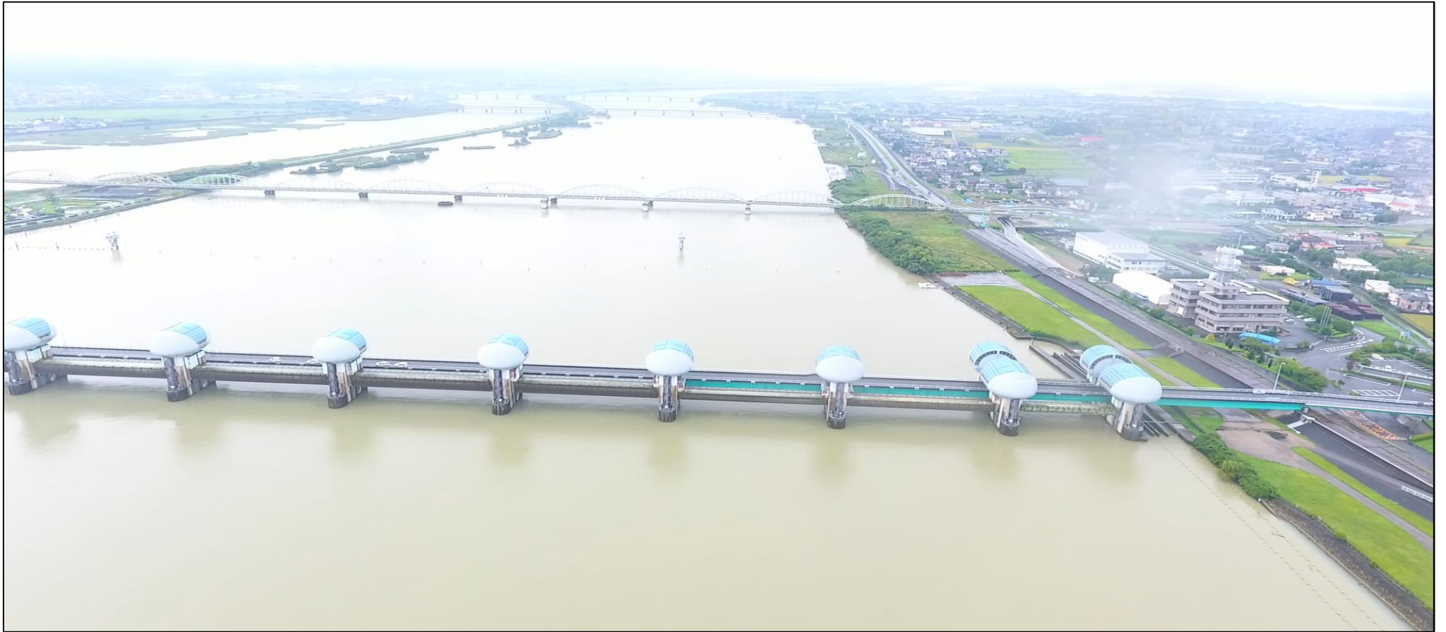
ゲート全開時の長良川河口堰(堰下流側)
