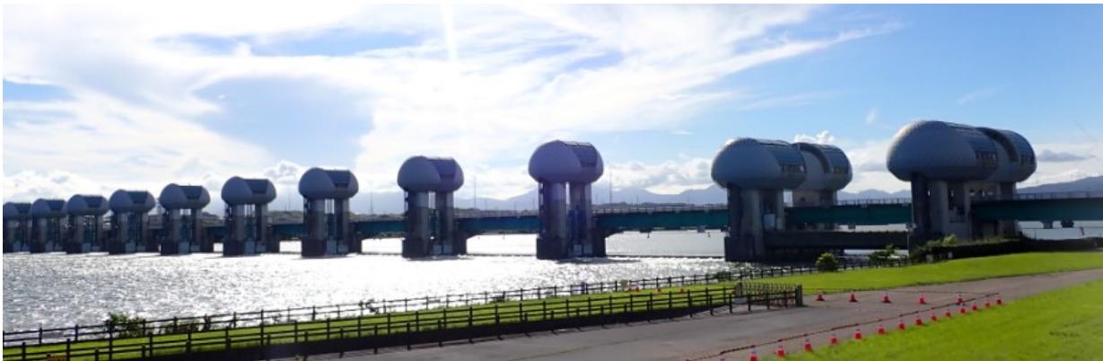
洪水操作後の長良川河口堰(下流より撮影)(7月28日16時頃)
