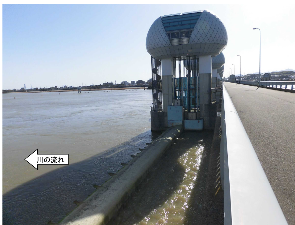
ゲート全開操作終了後の長良川河口堰（アンダーフロー操作に切り替え） 3月27日 16時撮影
