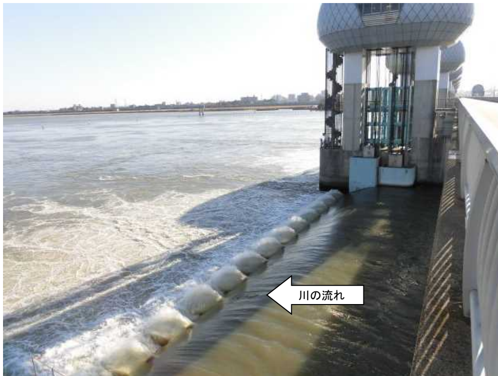
通常時の長良川河口堰(オーバーフロー操作による放流)
