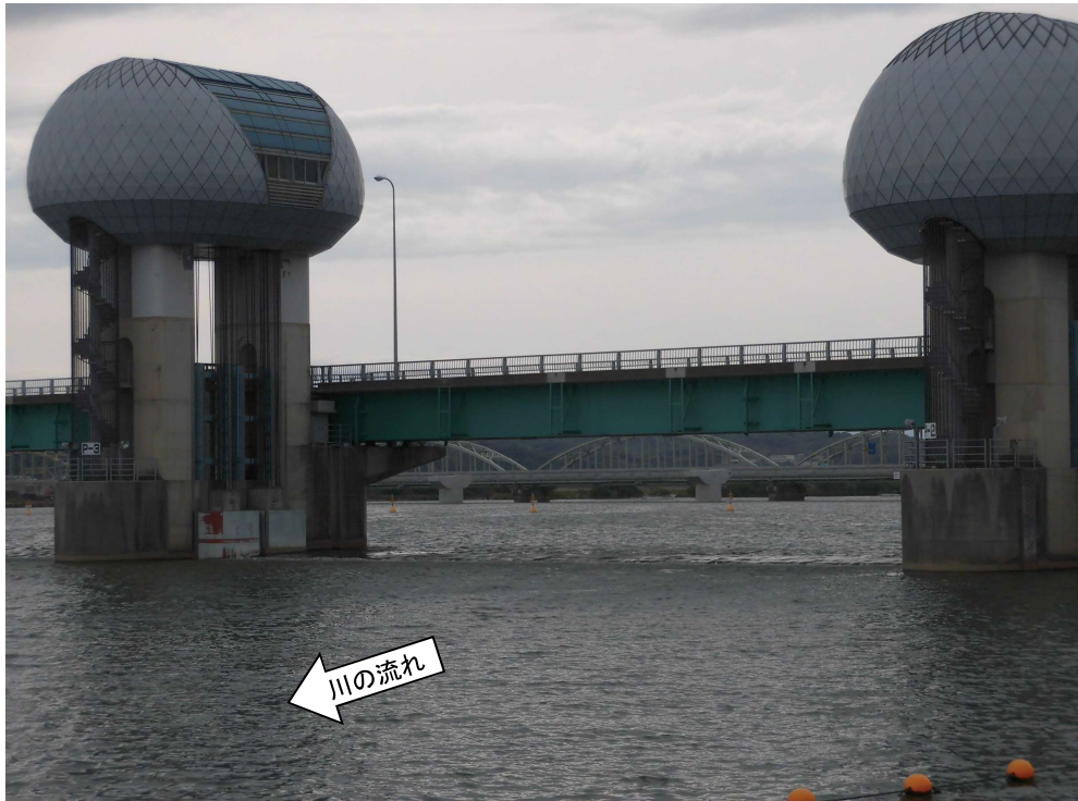
ゲート全開操作終了後の長良川河口堰（オーバーフロー操作に切り替え） 4月27日16時撮影
