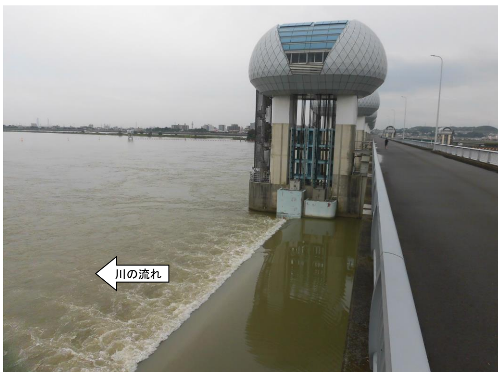
ゲート全開操作終了後の長良川河口堰（オーバーフロー操作に切り替え） 7月18日 7時撮影
