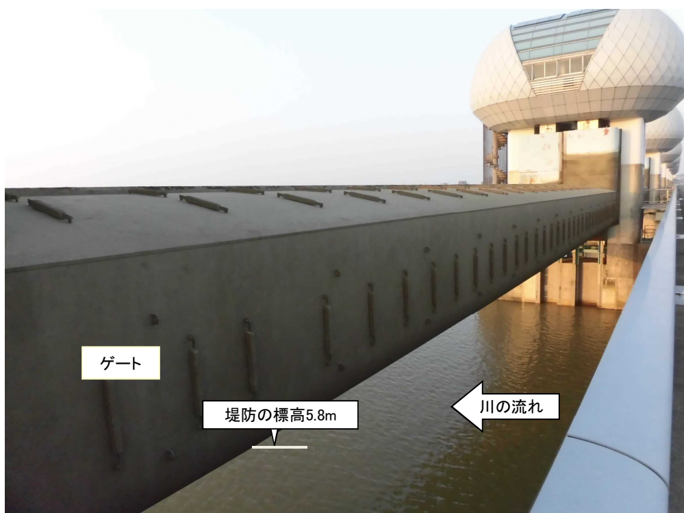
堤防より高い位置にゲートを引き上げ
