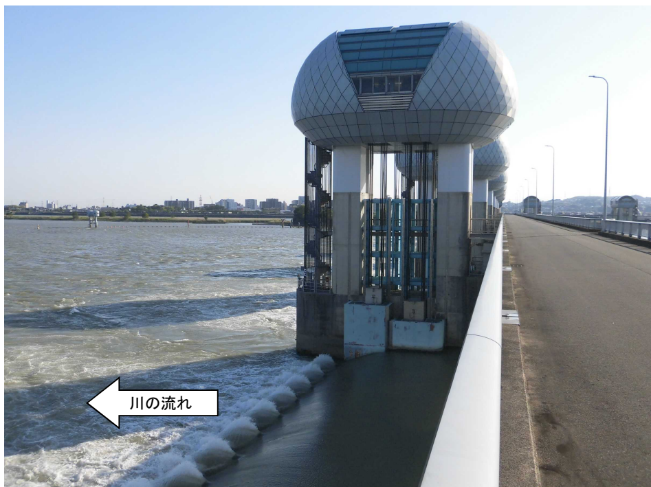
ゲート全開操作終了後の長良川河口堰（オーバーフロー操作に切り替え） 5月9日 17時撮影
