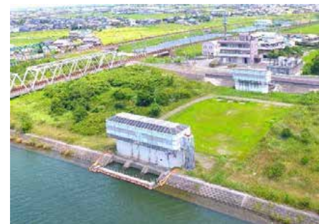
長良導水取水口
