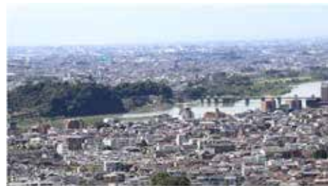
犬山頭首工付近(犬山市)
