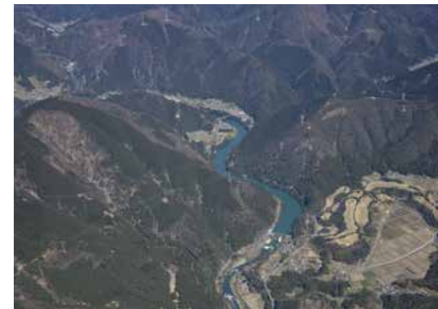
木曽川水系連絡導水路（取水工付近(揖斐川)）
