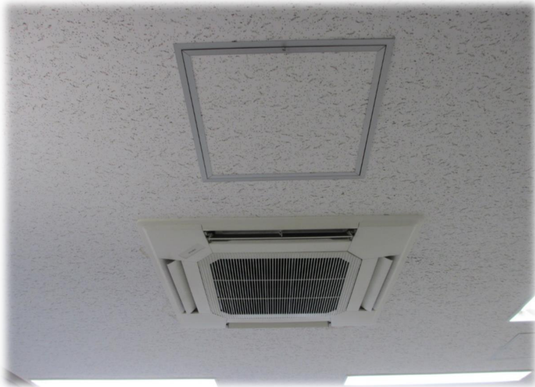
既設空調室内機AC-3の設置状況
