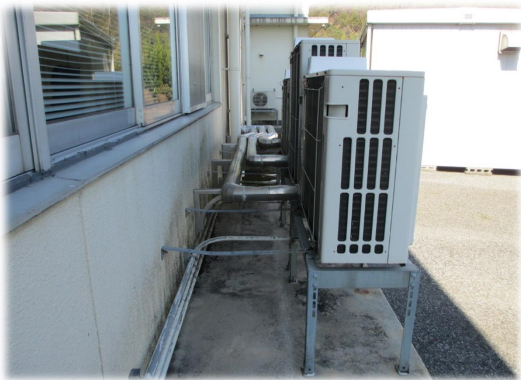
既設空調室外機AC-3配管状況
