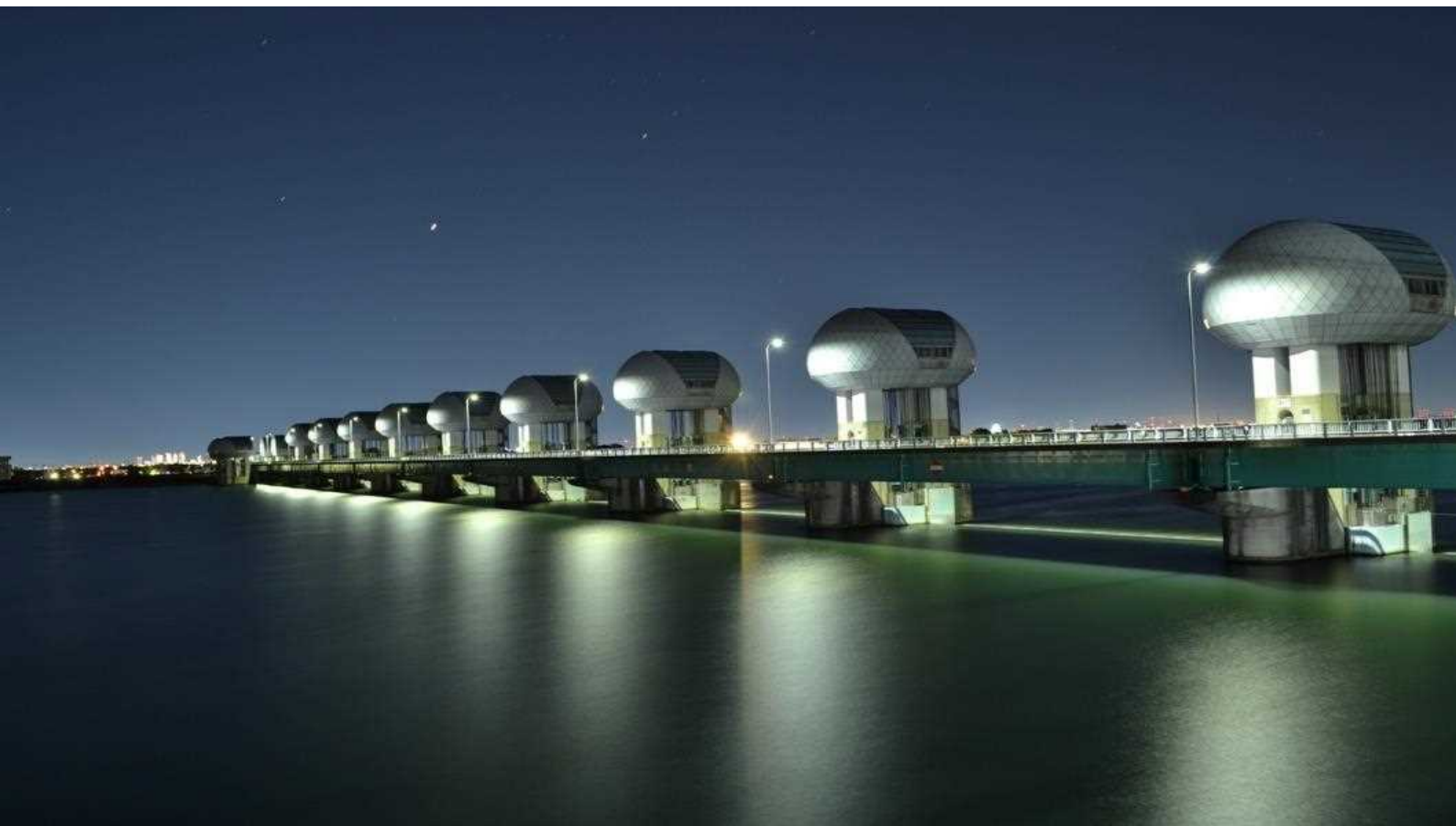
調節ゲートの照明に輝く長良川河口堰
