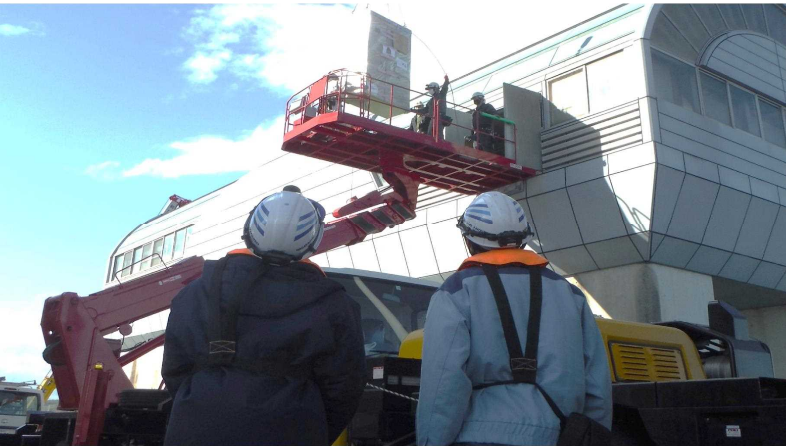
ゲート巻き上げ機室整備工事
