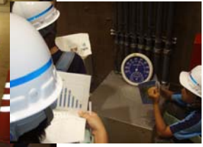
堤体内に設置した温度計
