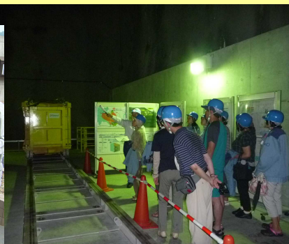
堤体内案内(ゲート室)
