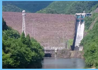
岩屋ダム 岐阜県下呂市
