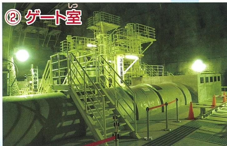
ゲート室は、堤頂から130メートル下にあります。選択取水設備で取水された水を、このゲート設備によって量を調節し放流しています。
