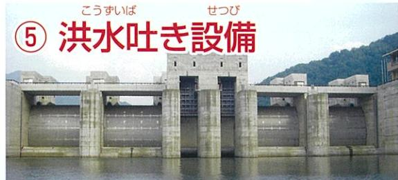
洪水吐き設備は、ダムに貯め込んだ洪水を、洪水がおさまった後にダム下流へ安全に流すために設置されたものです。全部で、6門の洪水吐きゲートがあります。
