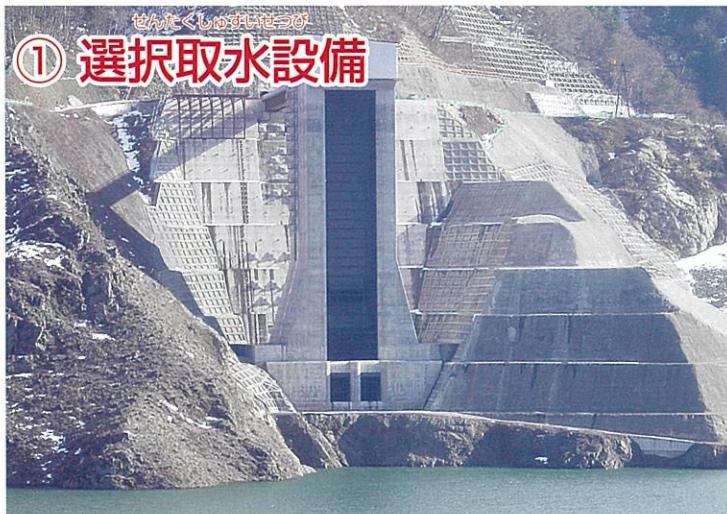
選択取水設備は、ダムの水を下流に流すための施設です。下流の魚や植物の生育に影響を与えないよう水温・水質を選びながら下流に流しています。
