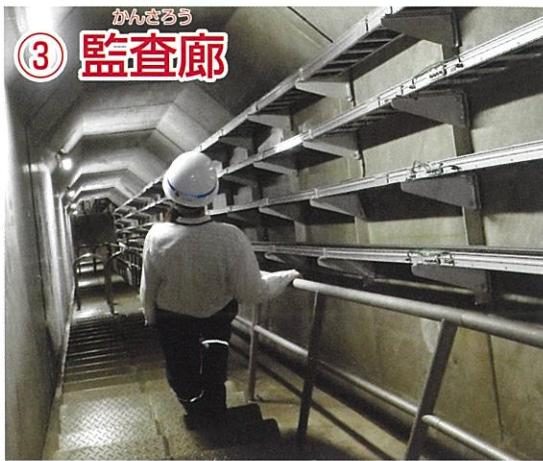
監査廊はギャラリーともよばれ、ダムの内部を点検するために設置された通路です。階段は全部で1358段もあり、ここを歩いて、ダムの中を点検します。
